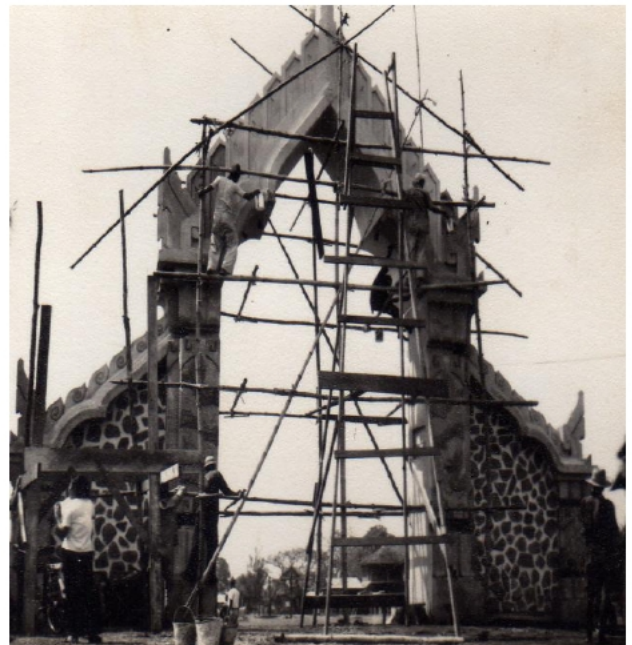
ซุ้มประตูวัดหลวงอรัญญูฯ ในขณะที่ทำการก่อสร้าง
